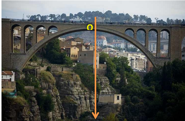
الشكل (1) جسر سيدي راشد
